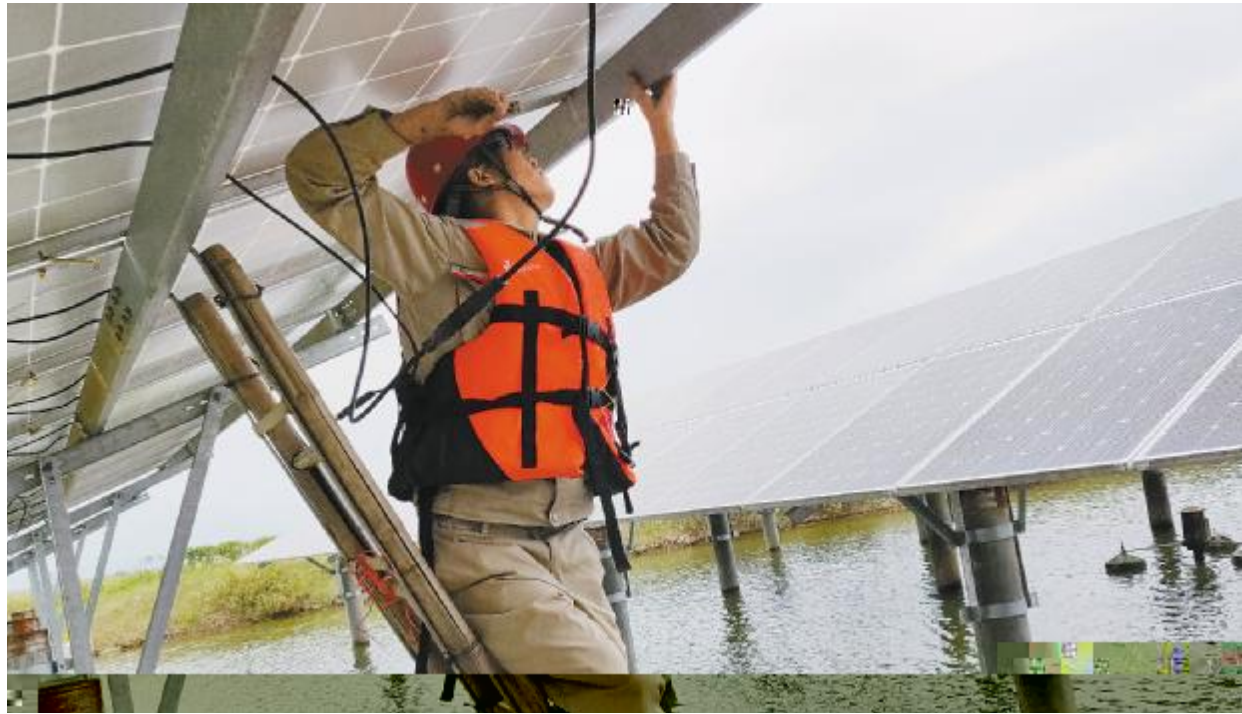
雨季防风隐患排查
