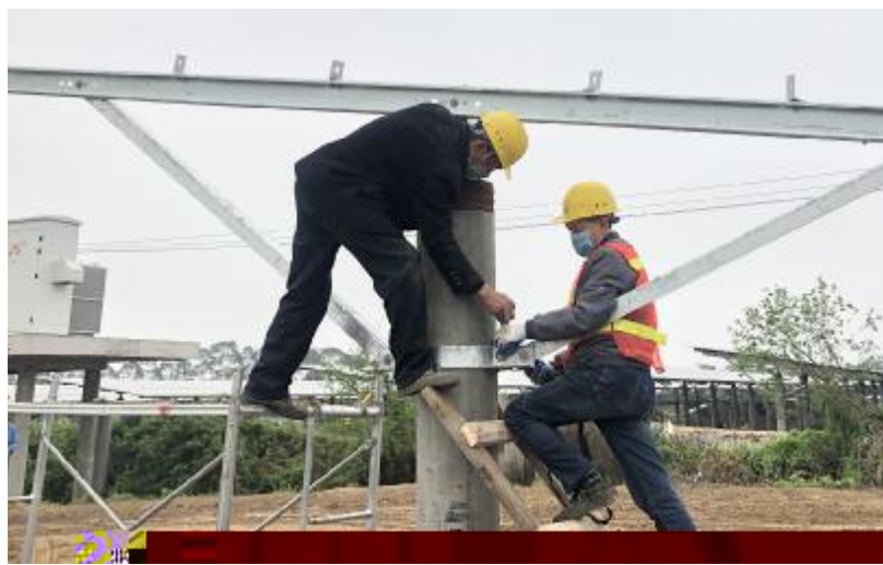
1. 45项目N工现场
