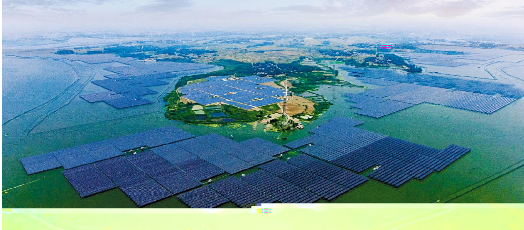
“渔光” 通威 “渔光一体”
