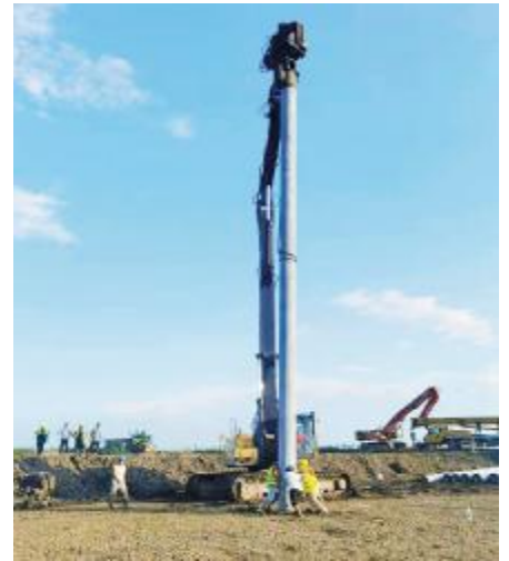
台山项目布下第一根桩
