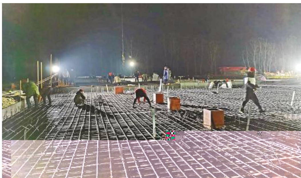
施工质量、建设进度“两手抓、两手硬”
