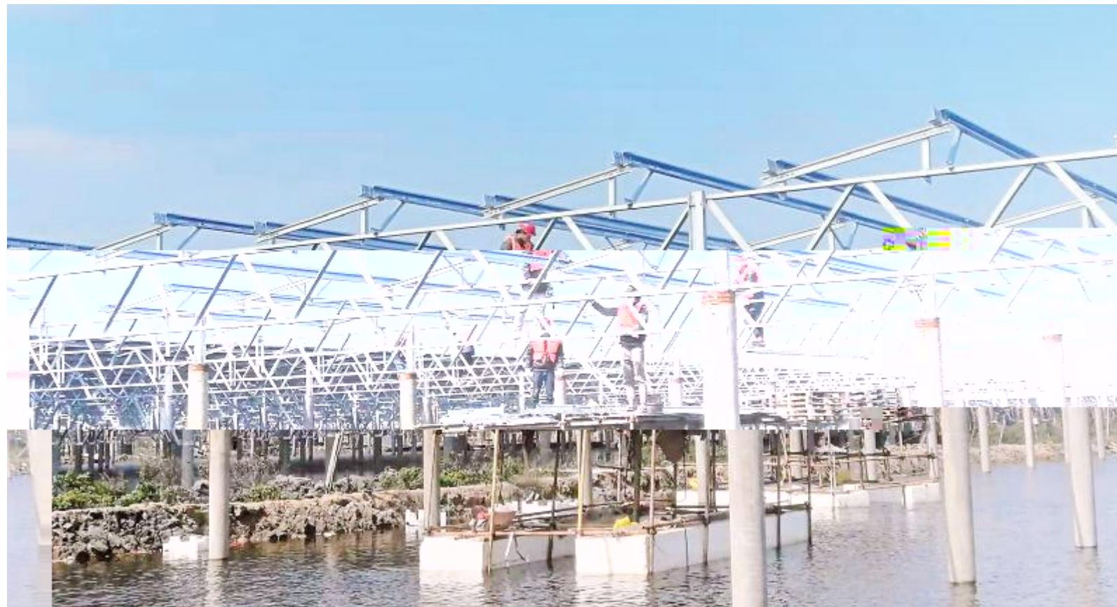
“渔光一体”项目建设现场
