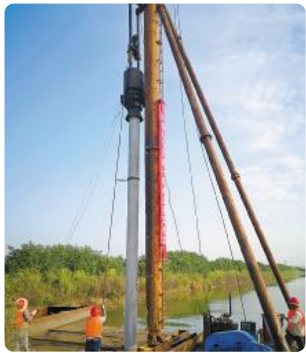
2021年10月2日,通威天门“渔光一体”一期项目开工
