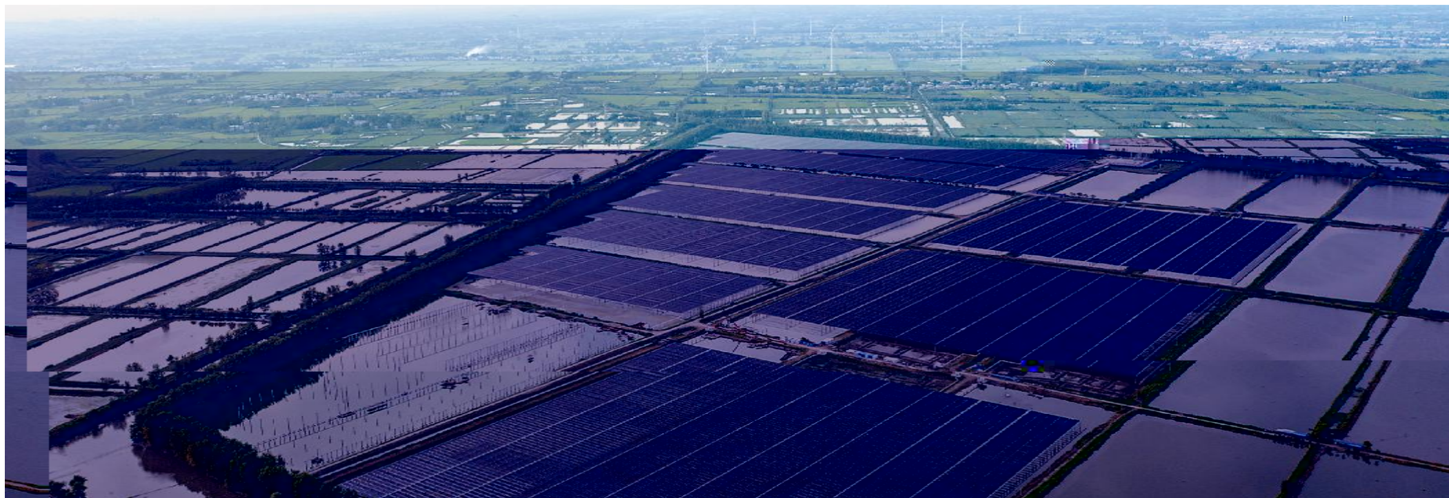
通威天门“渔光一体”一期项目
