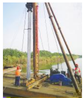
2021年10月2日，通威天门一期100MW“渔光一体”项目开工
